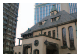
東京ガーデンテラス 紀尾井町 (2016年7月オープン)
